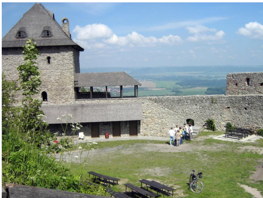
FOTOGRAFIE NABÍZÍ POHLED ZE ZŘÍCENÝCH PALÁCŮ SMĚREM NA SEVER A POHLED NA VSTUPNÍ VĚŽ S TERASOU.
